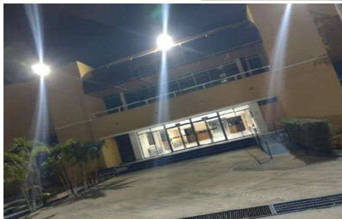
Fotografías 27. Cambio de luminarias por LED
