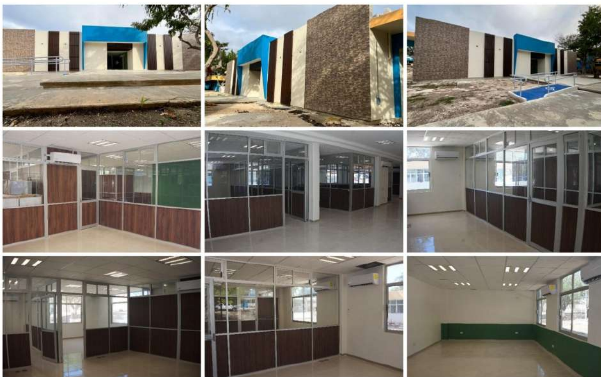
Fotografías 3. Rehabilitación Integral de Ex-Biblioteca
