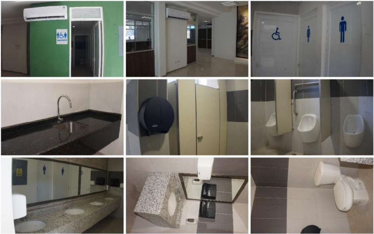
Fotografías 4. Rehabilitación Integral de Ex-Biblioteca
