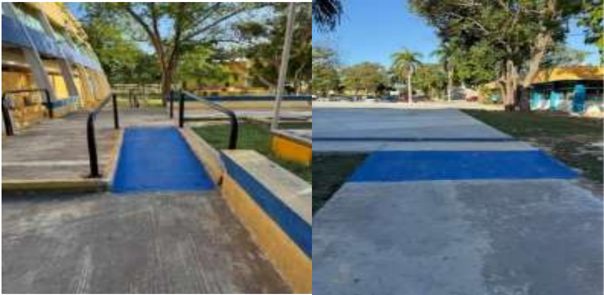
Fotografías 11. Rehabilitación de rampas para fortalecer las condiciones de inclusión y accesibilidad
